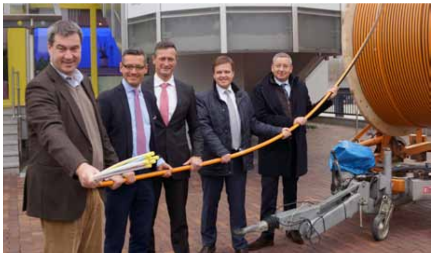
Start für den Glasfaserausbau im bayernhafen Nürnberg: v.l. Bayerns Finanz- und Heimatminister Dr. Markus Söder, Nürnbergs Wirtschaftsreferent Dr. Michael Fraas, Werner Prucker, Leiter Produktion Technische Infrastruktur Nürnberg bei der Deutschen Telekom, Joachim Zimmermann, Geschäftsführer der bayernhafen Gruppe, und Alexander Ochs, Geschäftsführer der Betreibergesellschaft des bayernhafen Nürnberg, der Hafen Nürnberg-Roth GmbH
